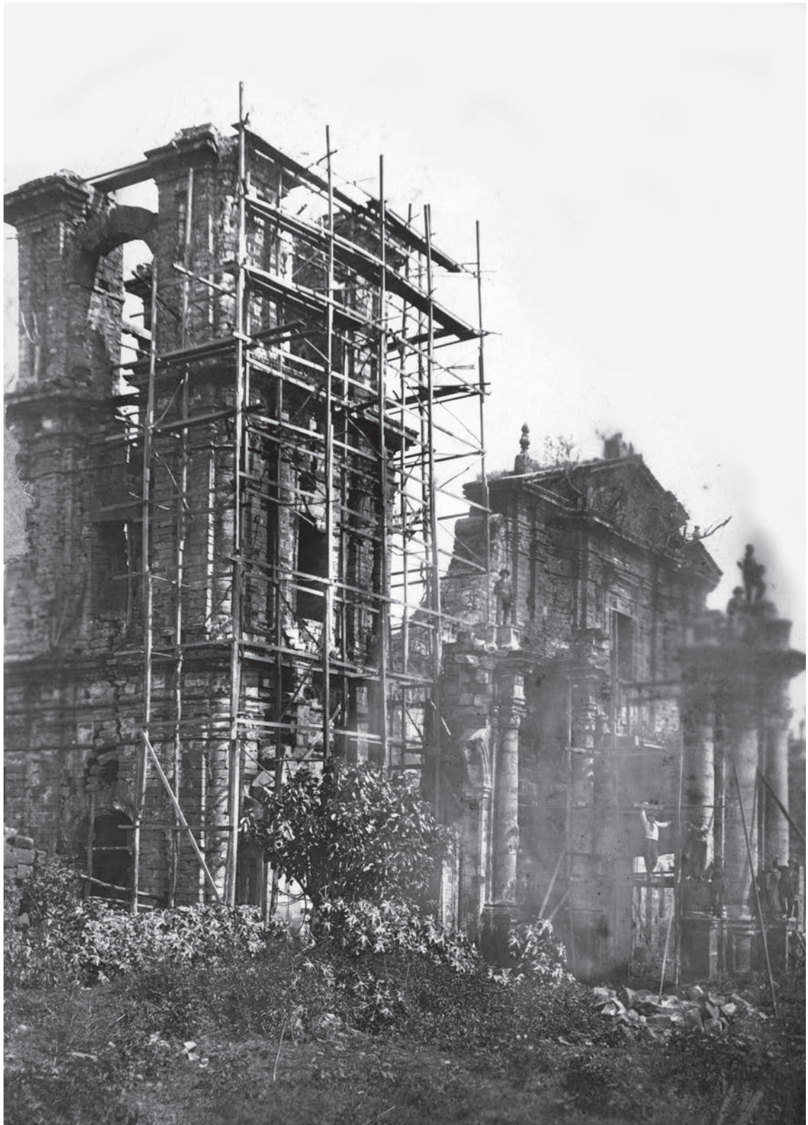
Trabalho de consolidação da Torre da Igreja de São Miguel Arcanjo, iniciado após a visita técnica de Lucio Costa, em 1938, e o reconhecimento como patrimônio nacional. Acervo: Iphan.
