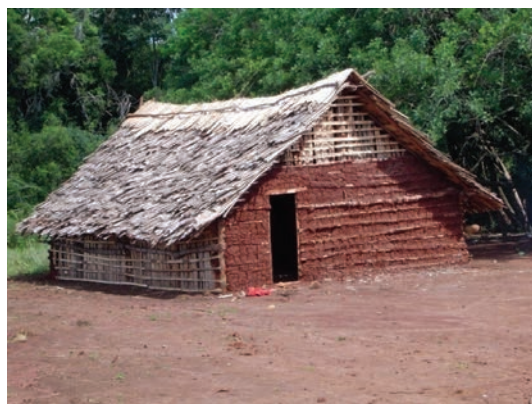
Opy (casa de reza), Tekoa Koenju . Acervo: Iphan-RS. Opy (casa de oración), Tekoa Koenju . Acervo: Iphan-RS.
