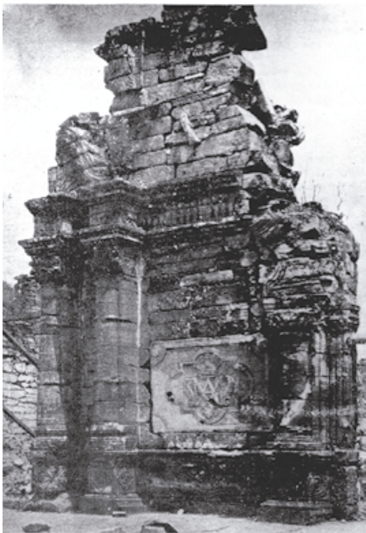
Santo Inácio Mini, fachada vista do oeste
